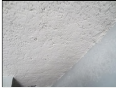
Photo N° 610 ECH-N°2 FLOCAGE -- LOCAL VELO Plafonds Blanc cotonneux
